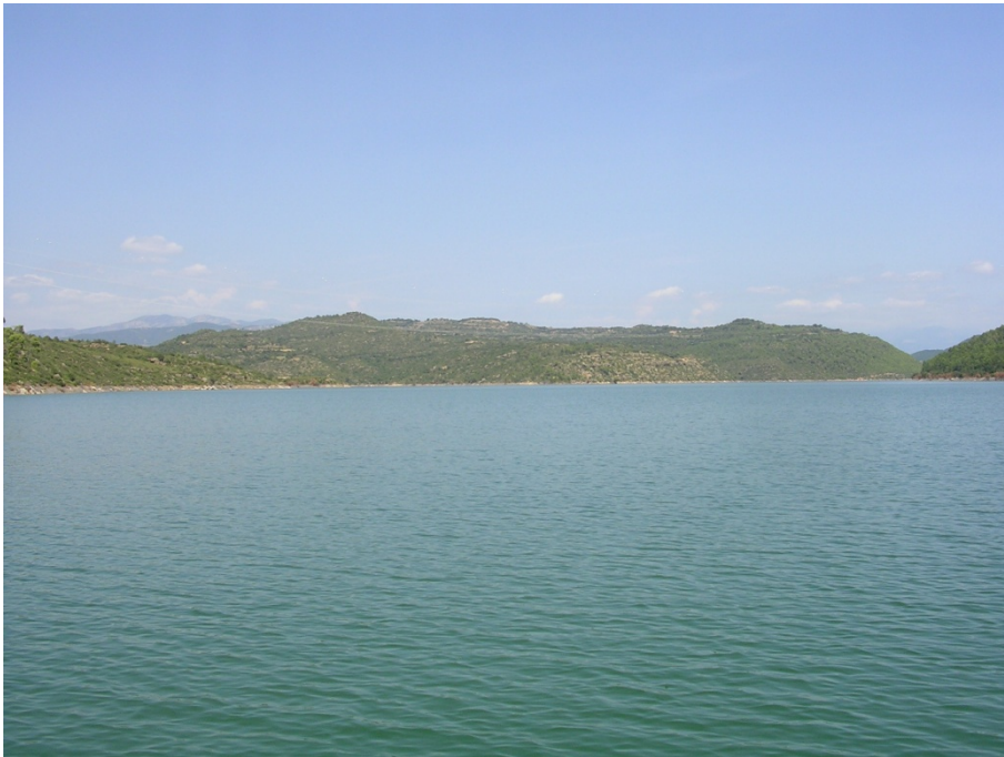
Figura 9. Vista de la cola del embalse
