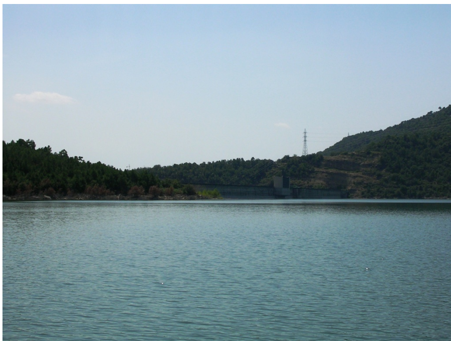
Figura 7. Vista de la presa del embalse
