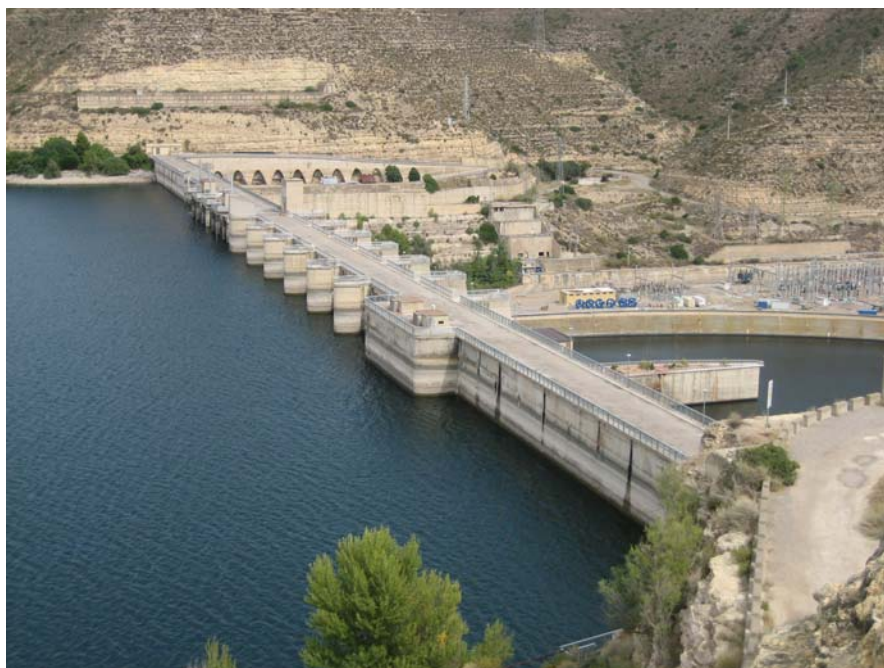
Foto 1: Vista general de la presa del embalse
