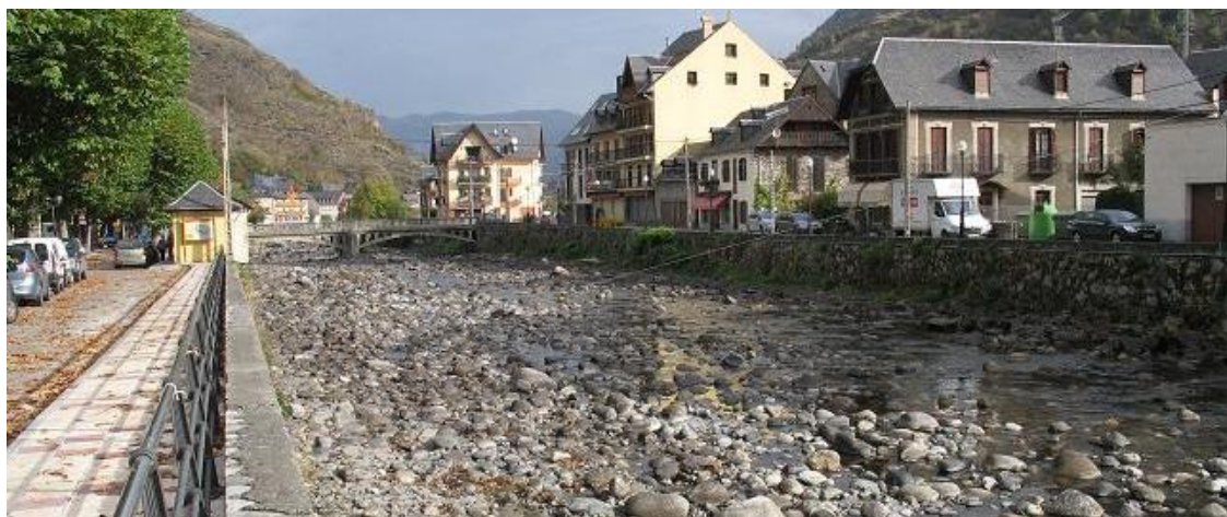
Figura 56-10. Canalización del río Garona en la localidad de Bossost.
