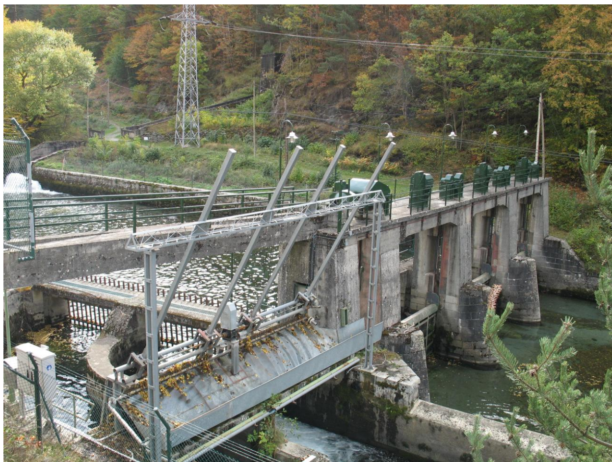
Figura 56-1. Río Garona en la central de Barradós.
