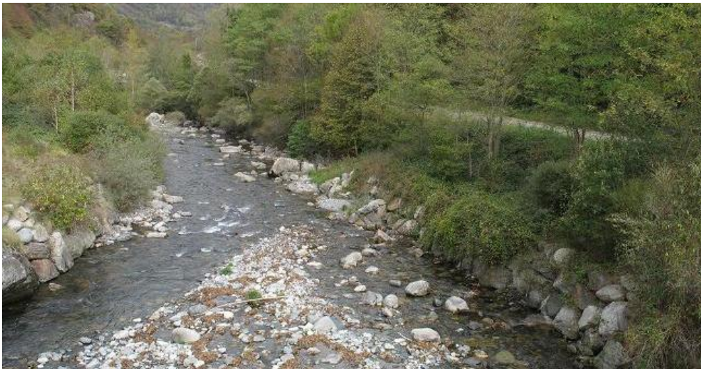
Figura 56-12. Río Garona aguas arriba de la localidad de Bossost. Escolleras laterales.
