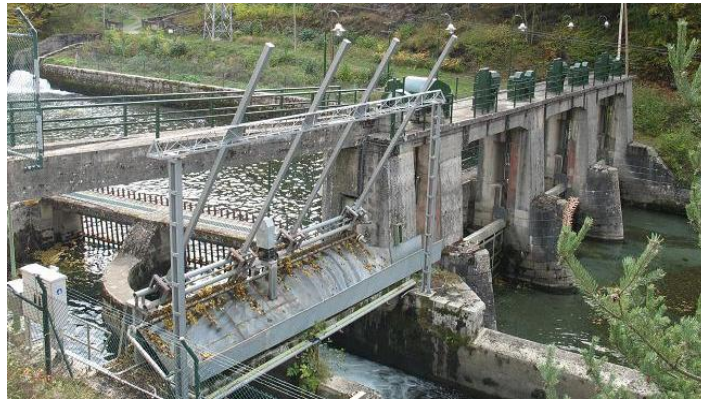
Figura 56-7. Azud de derivación hidroeléctrica.
