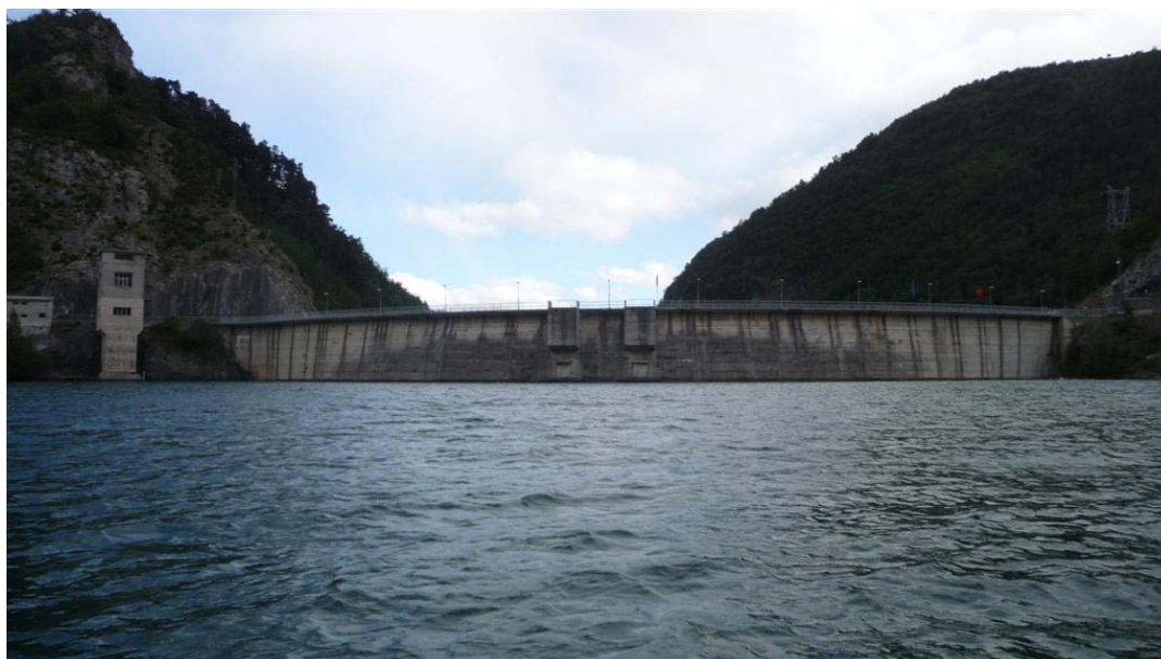
Foto 3: Presa del embalse de Lanuza
