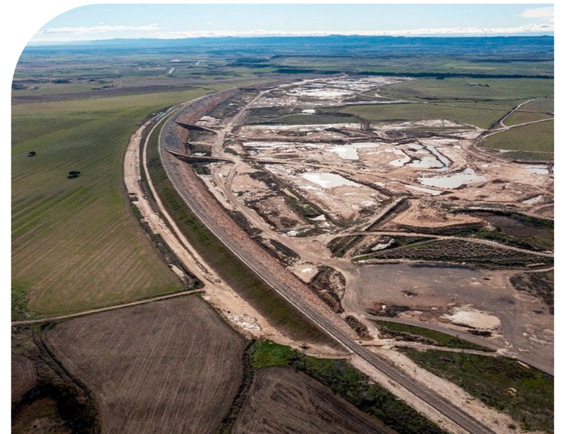
Estado actual dique este
