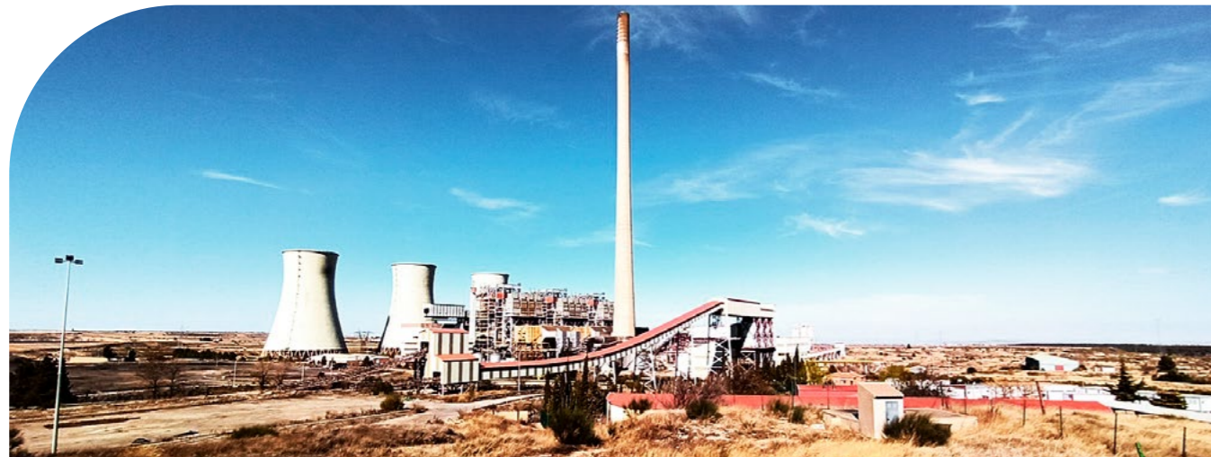
Central Térmica de Andorra
