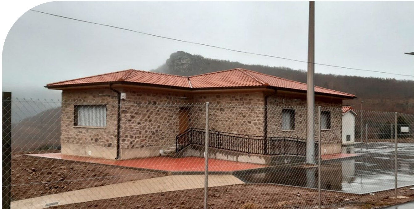
Edificio de emergencia en la margen derecha de la presa de Pajares
