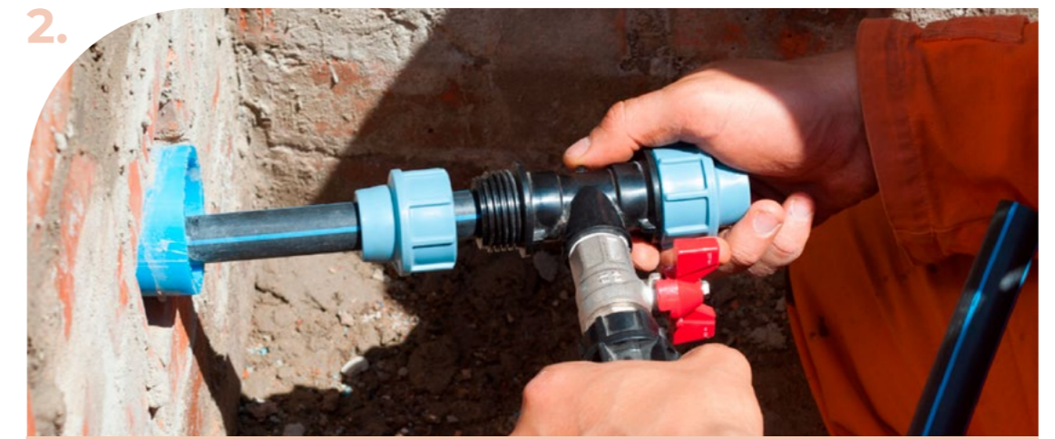
Actuaciones para la mejora de abastecimiento a Fornillos, Huesca
