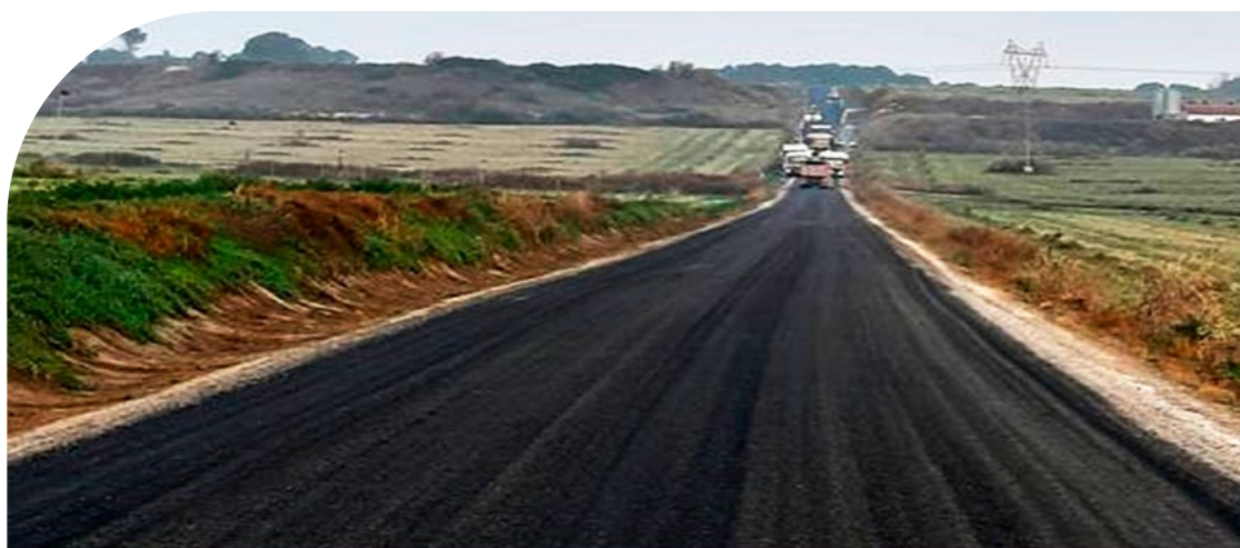
Carreteras de la zona regable del canal de monegros
