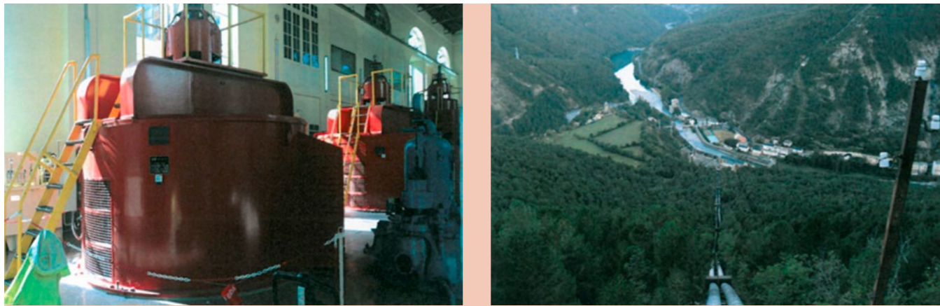
Central Hidroeléctrica Lafortunada-Cinqueta
