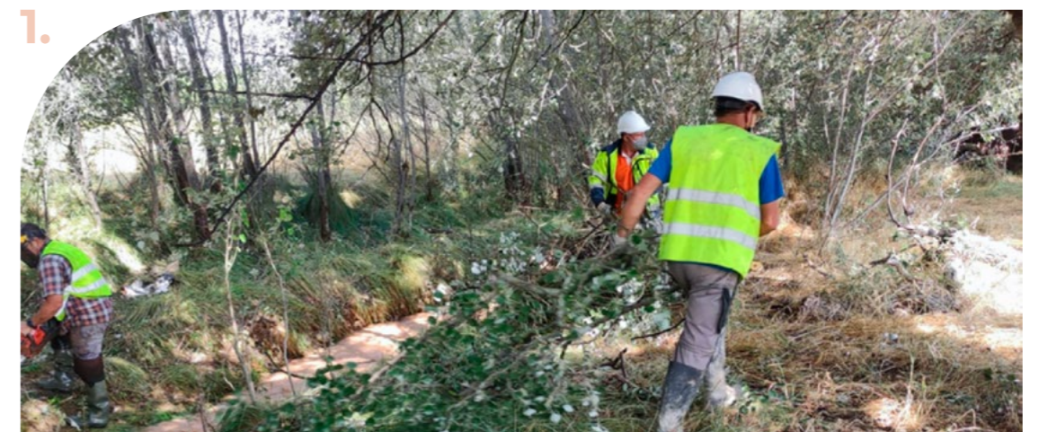
Mantenimiento de cauces
