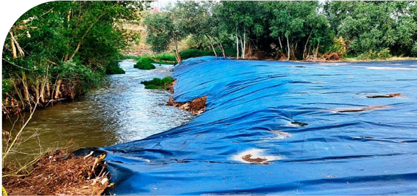
Eliminación de la caña Arundo donax. Río Alhama en Alfaro (La Rioja)
