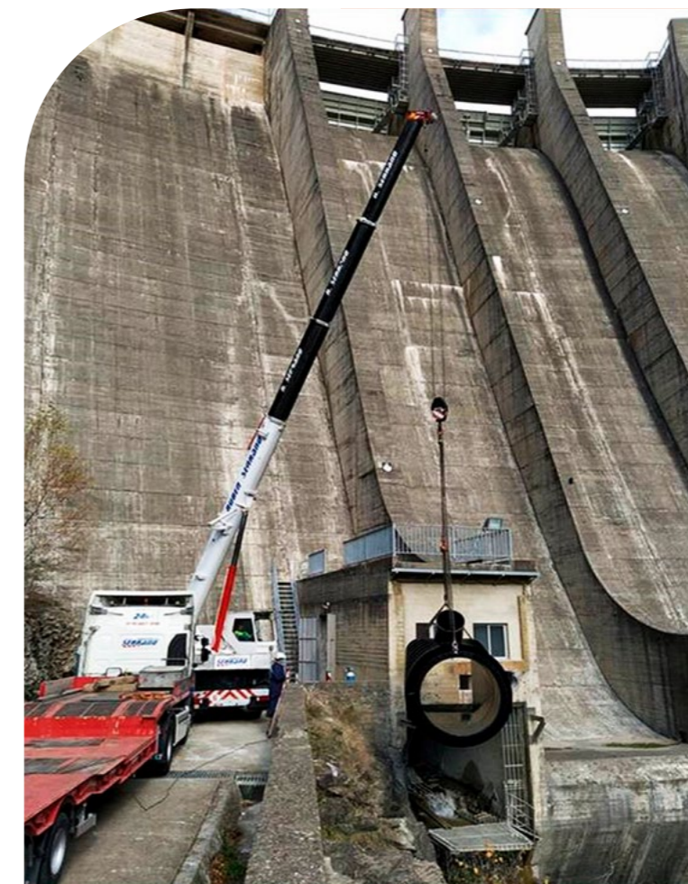
Desagües de fondo de la presa
