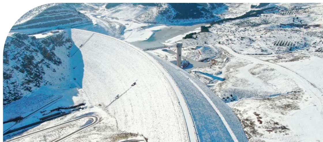
Presa de Mularroya
