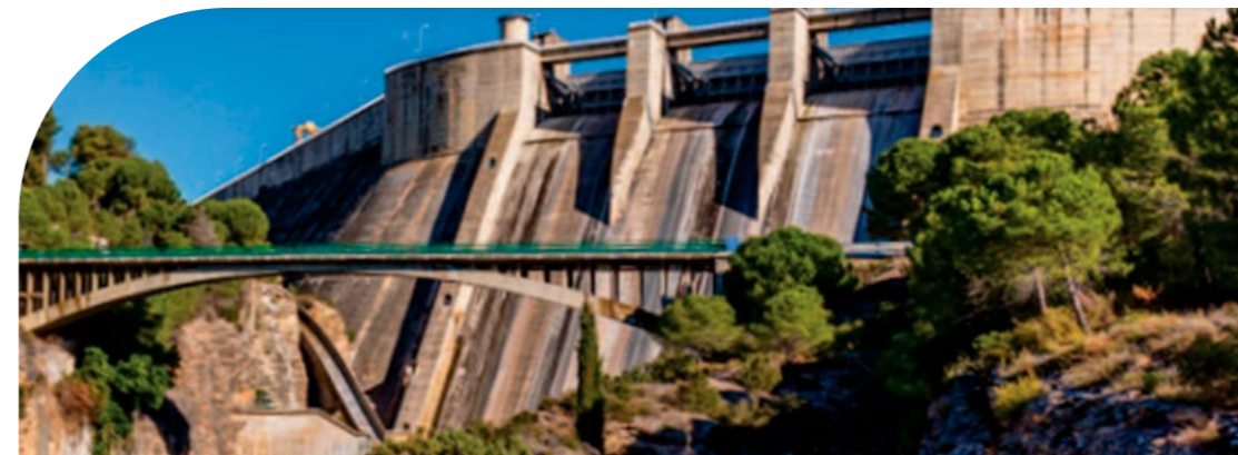
Presa de el Grado
