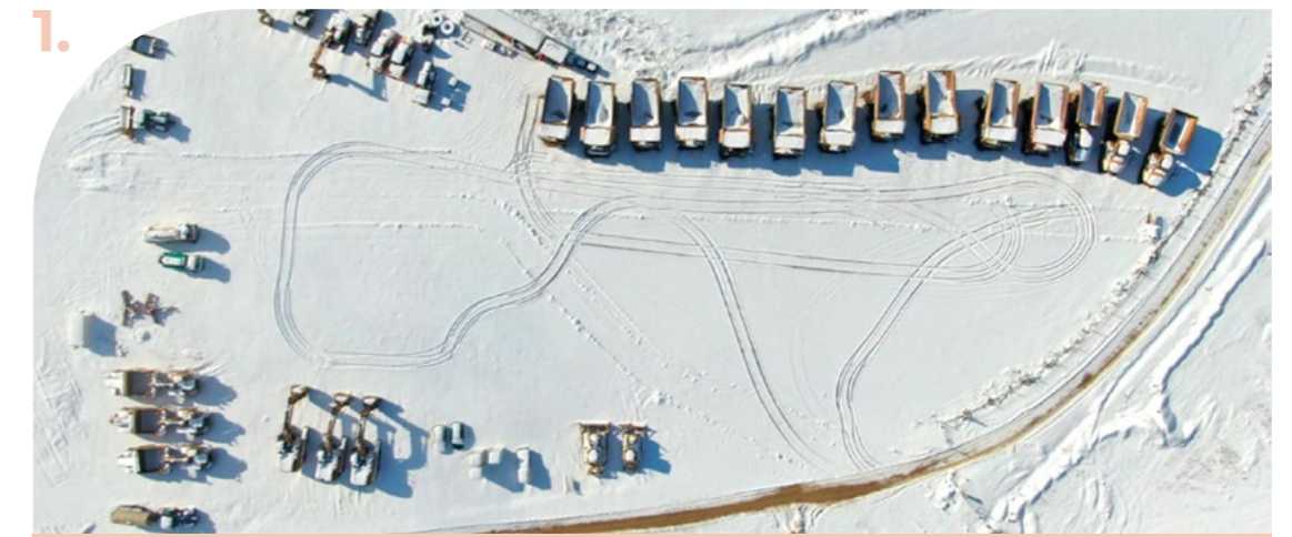
Obras del embalse de Almudévar, Huesca
