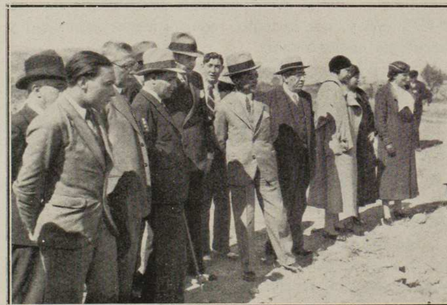
EN LAS OBRAS DEL PANTANO DE LA SOTONERA
