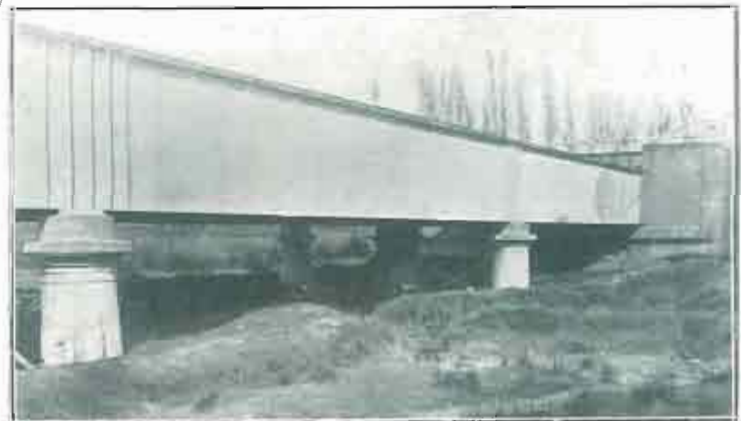
CANAL DE URGEL. Sifón acueducto sobre el río Sió.
