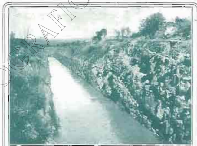
TÚNEL DE MONCLAR, Trinchera de salida.
