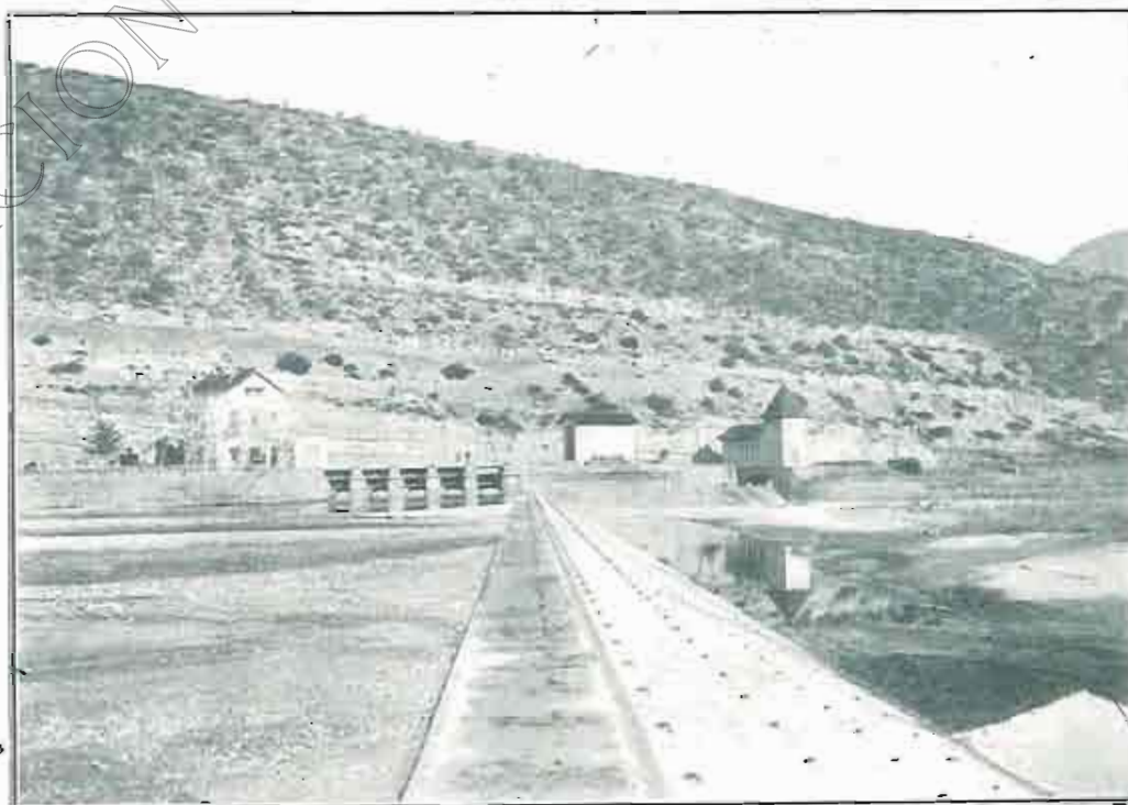
Casita de producción eléctrica para la obra, con desagüe de fondo y aliviadero de superficie.
