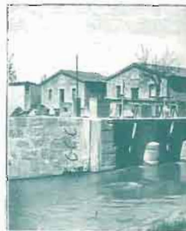
CASILLA Y TOMA DE LA PR
