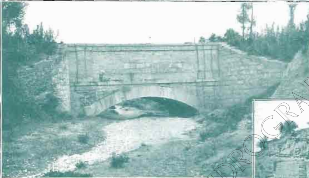
Acueducto sobre el río Cervera. (Kilómetro 74 del Canal, término de Anglesola)
