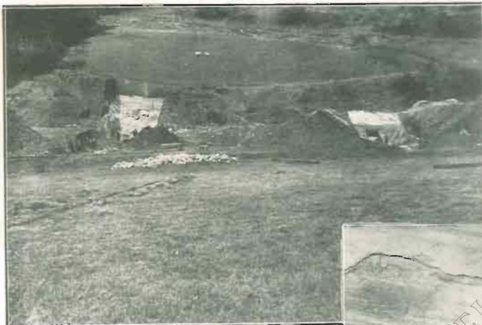
Bocas de ataque de los túneles de fondo por el frente de la descarga
