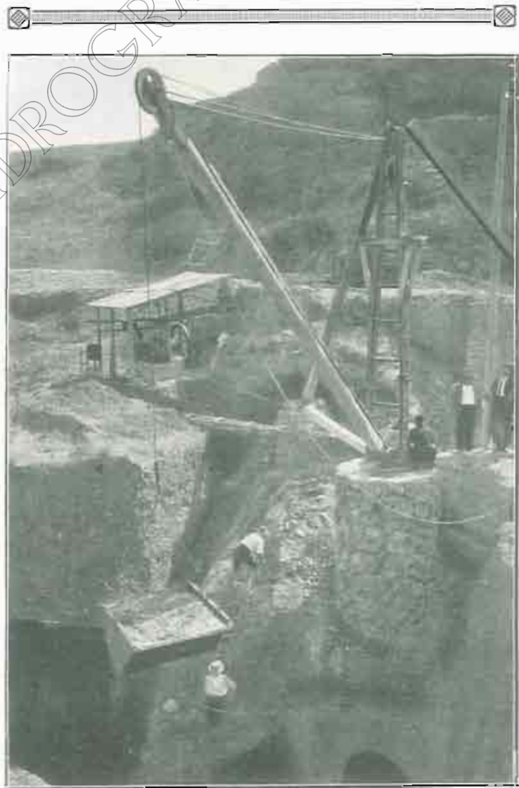
PANTANO DE MONEVA. Cimientos aguas abajo de la presa, para la ataguía de desviación de las aguas de riego.
