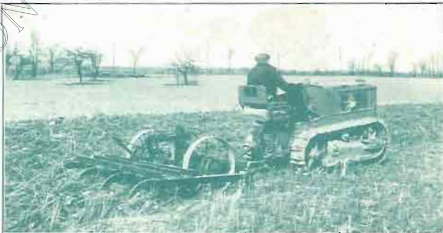
"CATERPILLAR", 2 TONELADAS CON CULTIVADOR-ESCARIFICADOR "KILLEPER", DE 1,50 M. DE ANCHO
