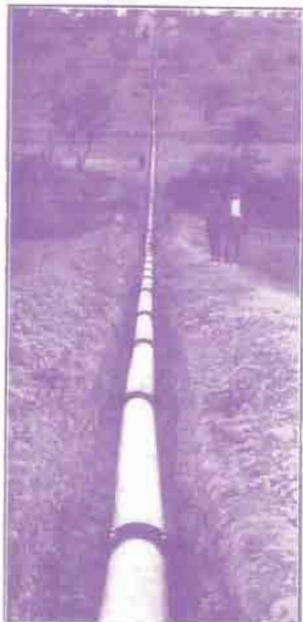
CONDUCCIÓN DE AGUAS EN ORZUELA (Lérida) 1400 metros longitud. - 250 mm diámetro. - 10 ejemplares.
