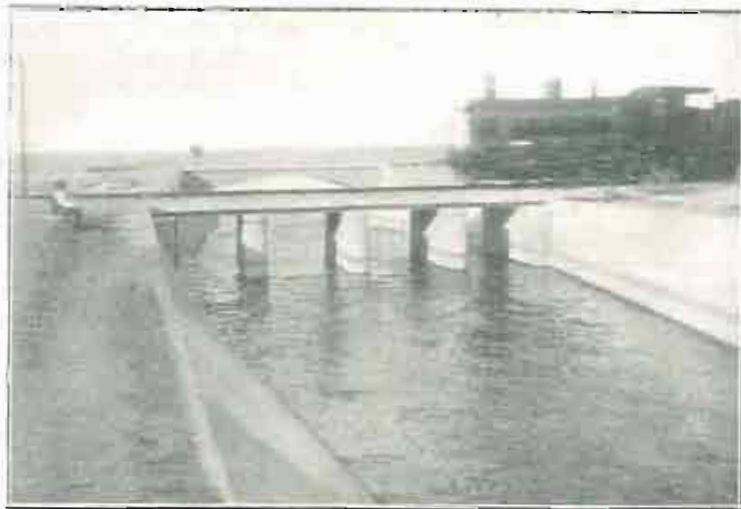
CANAL VICTORIA ALFONSO: Paso del rápido sobre un puente del Canal.
