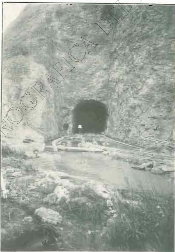
PANTANO DE CUEVA FORADADA: Túnel de las compuertas.
