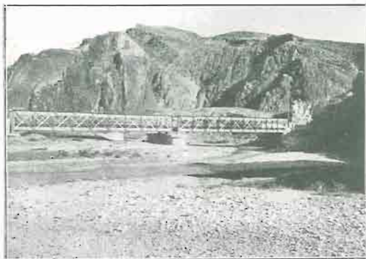
Puente del Ferrocarril de M. Z. A. casi enterrado por los depósitos de acarrees en el emisario principal de la Rambla de Ribota.
