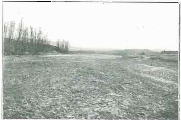
Materiales depositados en la Rambla de Ribota, en la que constituirá la roca del embalse
