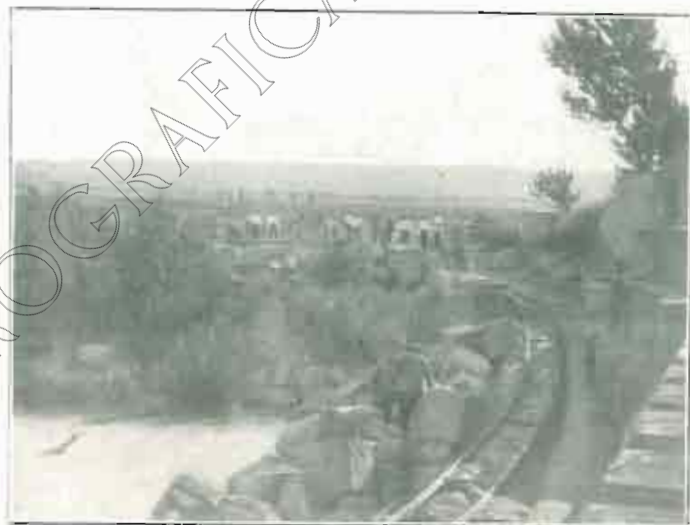
Octubre, 1927. - Estribo derecho de la Presa en su paramento de aguas abajo
