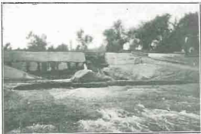
Avería ocurrida en la Presa de Pina, en Agosto de 1927
