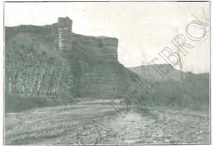
El castillo de Almontes, en la margen derecha de la Rambla de Ribota
