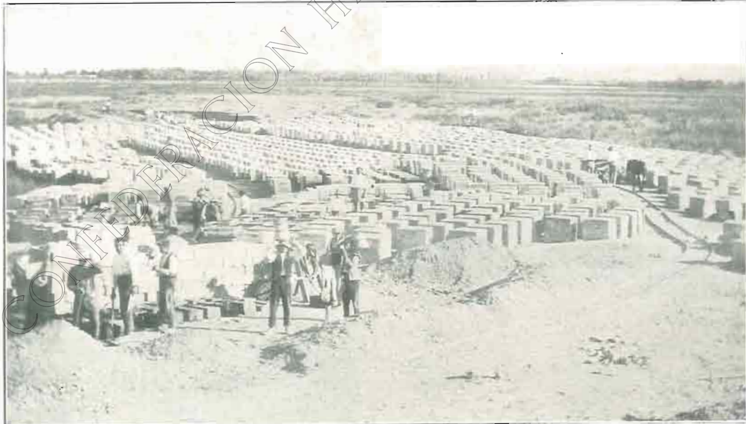
Octubre de 1927. — Taller de bloques para reparación de la Presa de Pina
