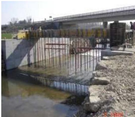
Estación de aforos en construcción
