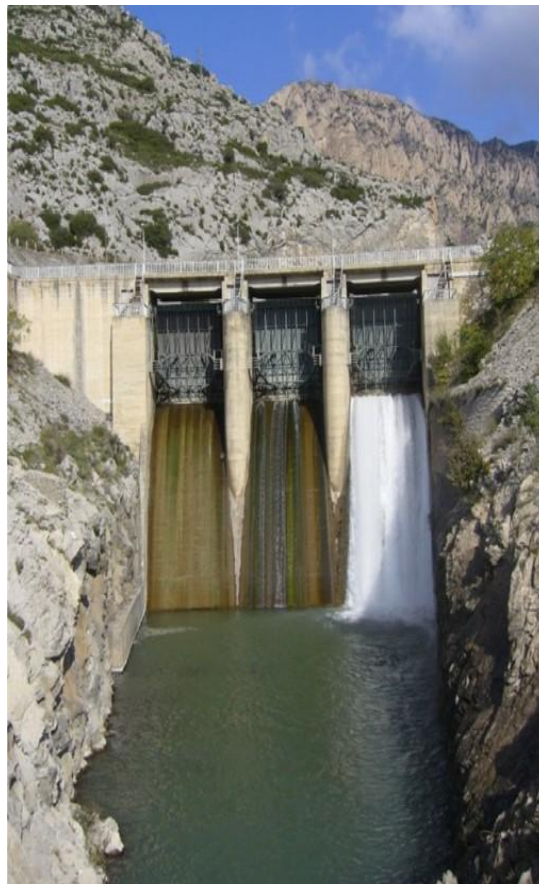
Vista general de la presa del embalse de Sopeira
