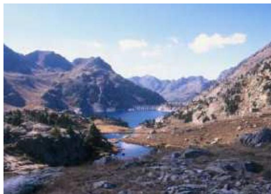
Obras del embalse de Respomuso
