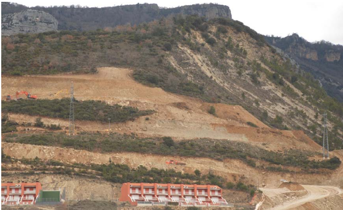
Figura 3.3.3: Vista del límite E de los depósitos de Flysch de Yesa en la ladera derecha del embalse. Se observa el escarpe erosivo coronado por los depósitos de flysch (zona de mayor pendiente) a los que siguen las Margas de Pamplona (zona más tendida).
