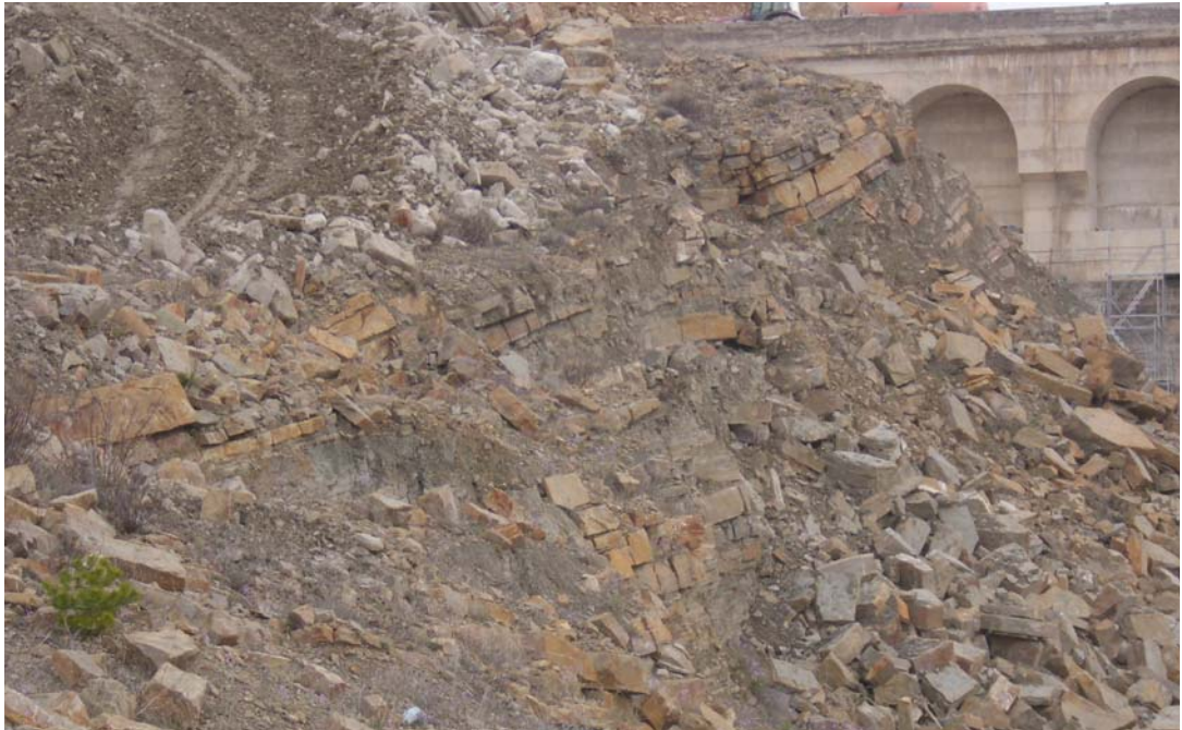
Figura 3.5.5: Detalle del buzamiento hacia el N que presentan las capas de flysch aguas abajo de la presa actual, al pie de la ladera, como consecuencia del sinclinal existente.
