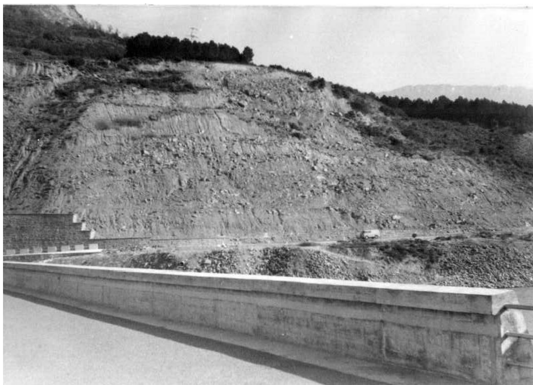
Figura 2.3: Fotografía del deslizamiento de la ladera derecha obtenida del “Informe de los resultados obtenidos de los sondeos efectuados y de los tubos piezométricos colocados en la zona del deslizamiento de la ladera derecha y en las cimentaciones del eje de la presa de Yesa (Navarra)” Servicio Geológico de Obras Públicas, 1966.
