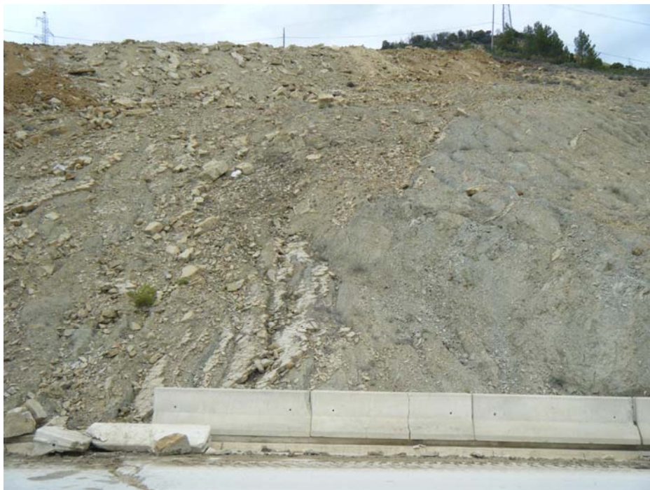
Figura 3.3.2: Vista del límite E del movimiento observado en la ladera en los materiales del Flysch de Yesa. Destaca la presencia de espesores importantes de margas en el terreno por la proximidad al sustrato margoso que aflora más al Este.
