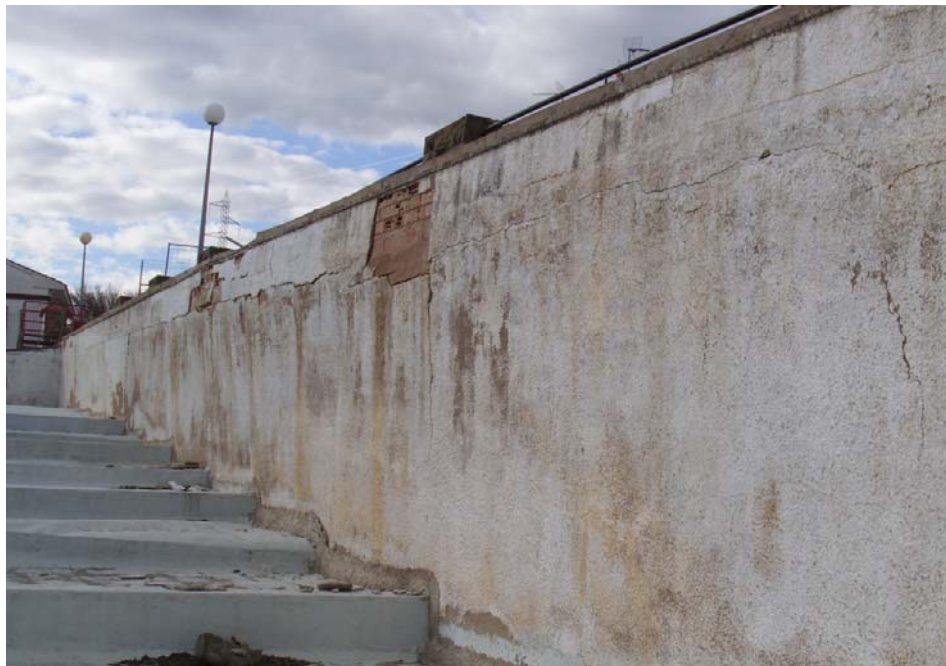
Figura 4.1.16: Vista de la pared de ladrillo sobre la que apoyan las viguetas del forjado que constituye la acera de la calle 3 de la urbanización Lasaitasuna, coincidiendo con el límite Oeste de la masa inestable. Se observa el cabeceo de la coronación de la pared, coincidiendo con la zona en la que se ha producido el hundimiento de la acera.
