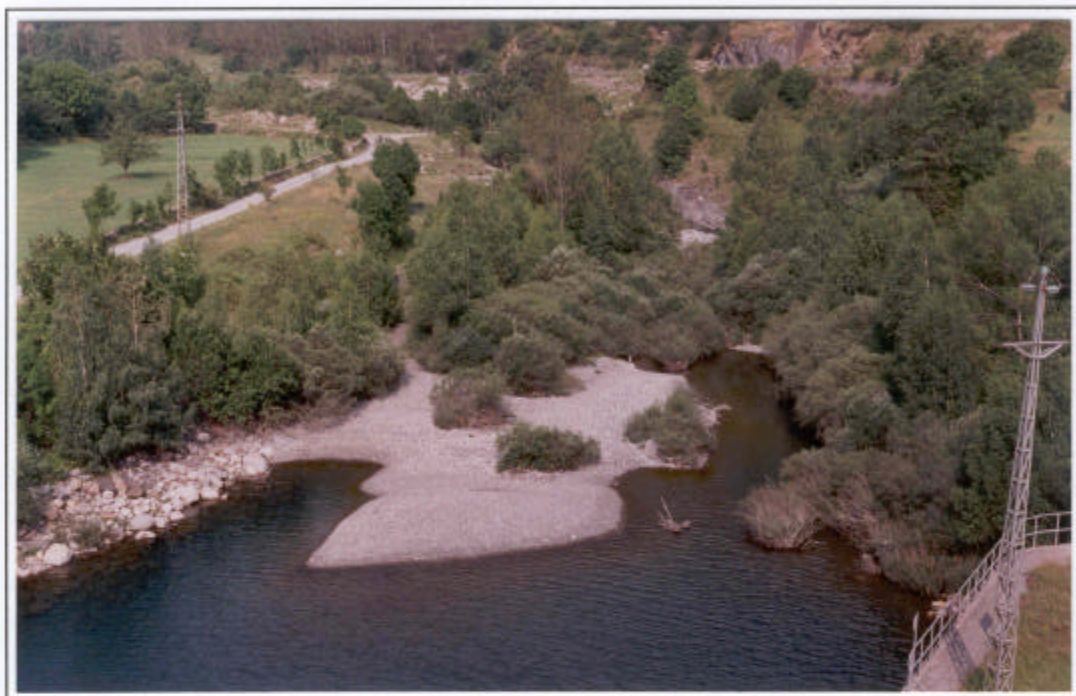
Río Ésera aguas abajo de la presa de Linsoles.
